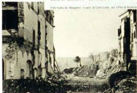
Colle S. Giovanni – demolizioni
