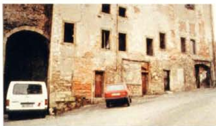
Facciata esterna, lato via Boccola del complesso del Carmine
