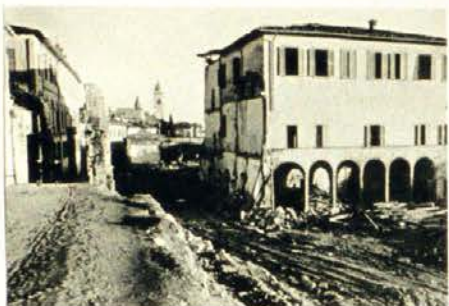
Colle S. Giovanni – demolizioni
