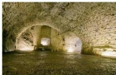
Il baluardo di San Giovanni restaurato nel 2009 dall'impresa Pandini
