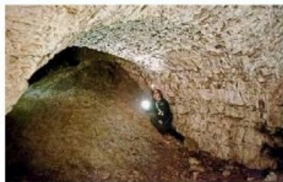
Il sotterraneo nel baluardo di San Giovanni durante le prime esplorazioni
